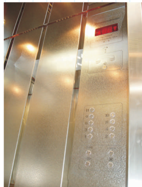
Нержавеющая сталь «Суперзеркало» для межмодульных балок
